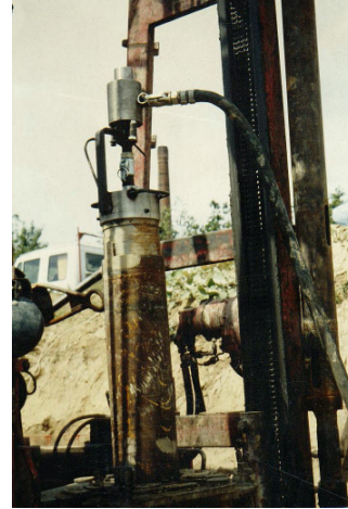
Verpressen von Suspensionen während des Eindrehens der HBS
