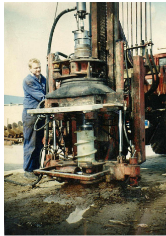
Abteufen der Hohlbohrschnecke zur Durchörterung des Müllkörpers
