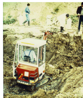
Freilegen der verpressten Bohrlocher und der plombierten Entnahmebereiche auf einem Teststandort in Schleswig-Holstein
