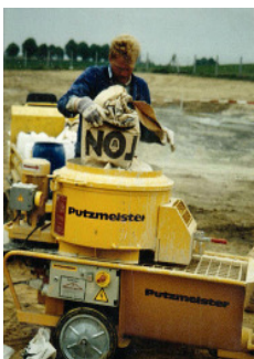
Anmischen der Dichtmassen-Rezeptur
