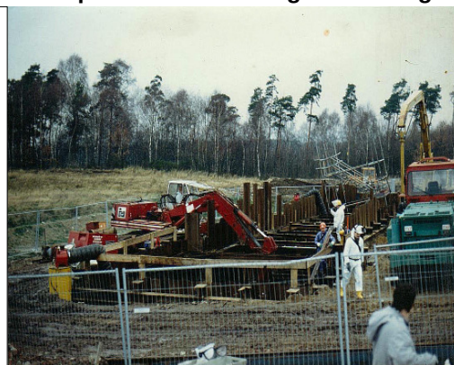
Schrittweise Durchörterung des Müllkörpers zur Beprobung und Entnahme von Bohrkernen aus der Basisdichtung der Deponie
