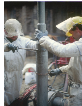
Öffnen der ORKUS-Sonde zur Entnahme des DEKADUR-Liners
