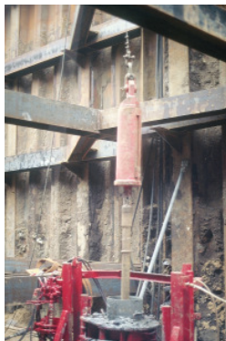
Einrammen der ORKUS-Sonde in die Basisdichtung
