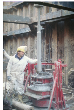
Ziehen der Sonde nach erfolgter Kerngewinnung
