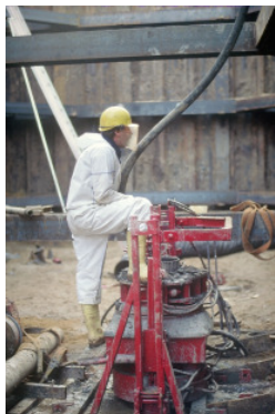
Einpumpen von Suspension vor dem Abteufen der ORKUS-Sonde
