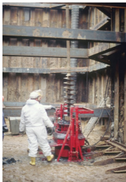
Eindrehen der Hohlbohrschnecke im Basisbereich des Müllkörpers
