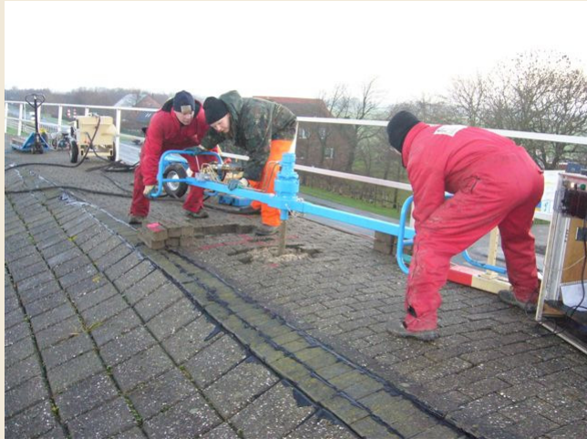
Ankerbohrungen
