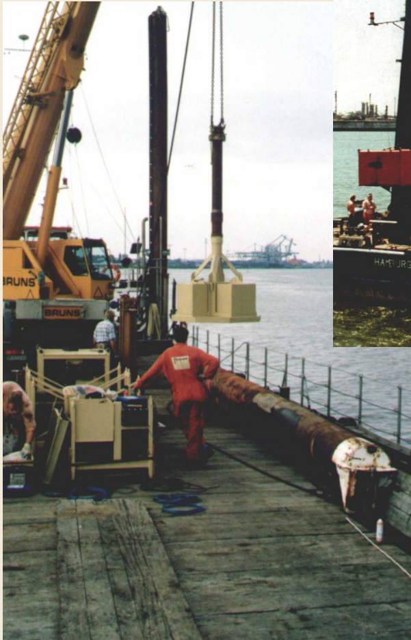
Vorbereitung an Deck
