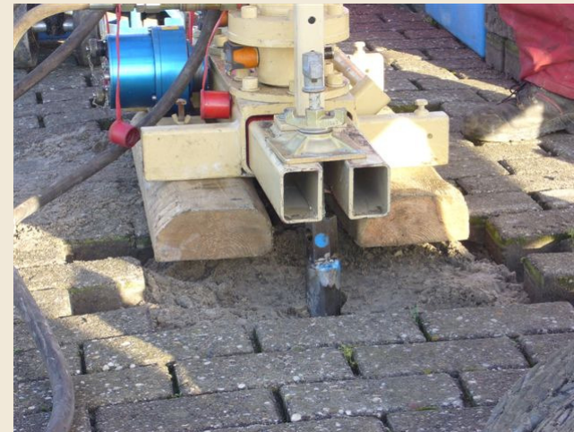
Befestigung der Sondierhydraulik am Anker
