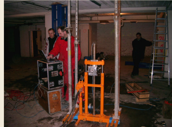
Abstützung eines losen Sondiergerätes gegen eine Geschosdecke in einem Parkhaus
