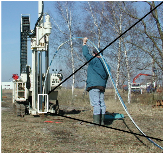
Installation eines Multilevelbrunnens: 20 m tief, 5 Probenahmehorizonte
